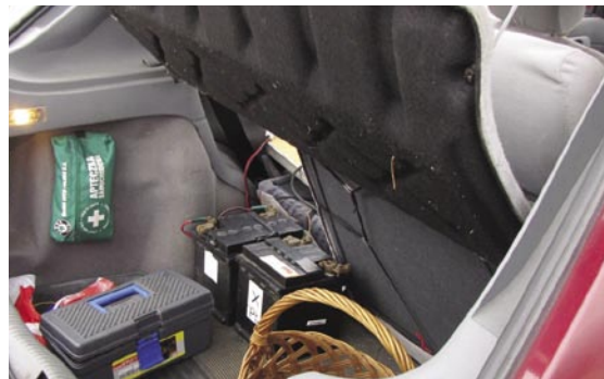
Baterie akumulatorowe zasilające stację
