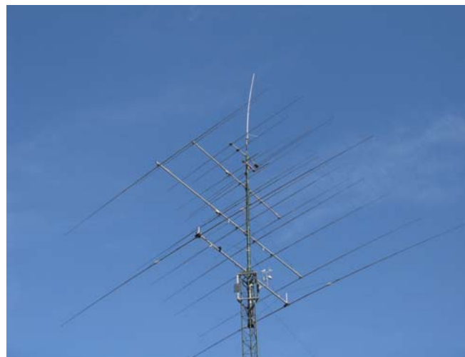
Anteny Wojtka SP2JFF. Na maszcie znajdują się anteny jednopasmowe (monobandery), 2 el. na 7 MHz, 6 el. na 14 MHz, 6 el. na 21 MHz
