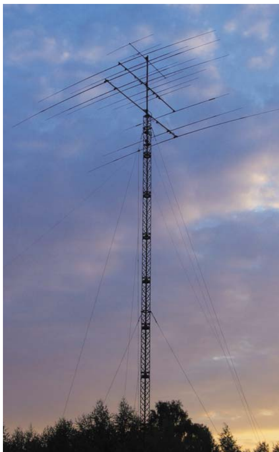
Zdjęcie na okładce – anteny Pawła SP7SP. Od góry: Yagi 5-el. na 50 MHz, Beam GXP-7, Beam 4-el. na 7 i 10 MHz.
