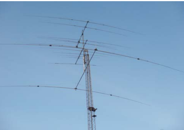
Anteny Marka SP7HOA. Na jednym maszcie znajdują się następujące anteny: najwyżej beam GXP-7, w środku beam duobander jako 2 el. na 7 MHz i 2 el. na 10 MHz, a najniżej beam 2 el. na 3,5 MHz
