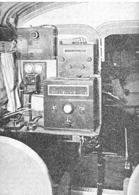
Radiostacja SFR ADC 4 w samolocie Farman Goliath
