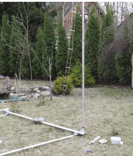
Montaż elementów w pionie
