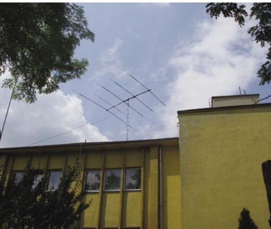
Widok na siedzibę Sekretariatu ZG PZK i Centralne Biuro QSL. Na dachu widoczna antena 5 elementowa na pasma 14–21–28 MHz
