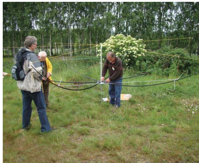
Wojtek SP5DPD (w środku w żółtej kurtce) montuje z pomocą kolegów antenę Hexbeam
