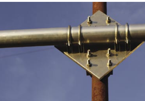
Mocowanie elementów anteny
